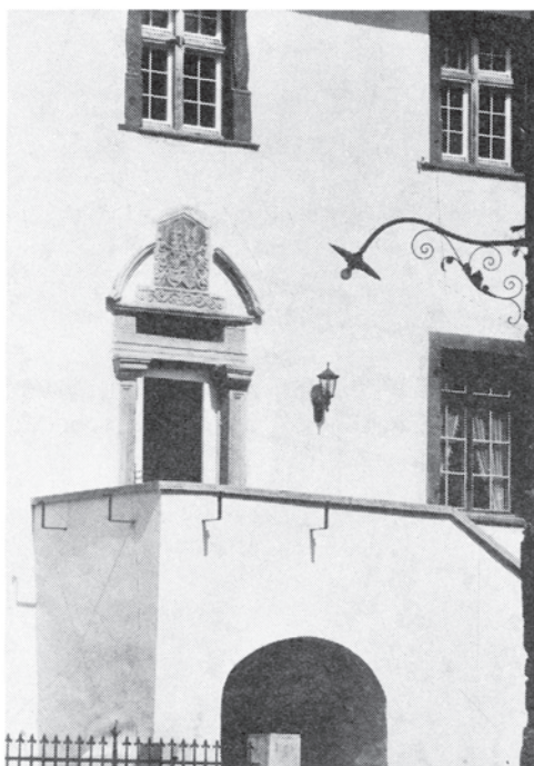
Eingangspartie des Patrizierhauses
