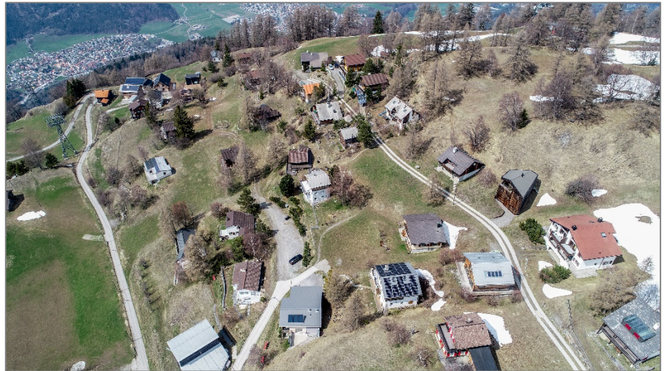
Abbildung 29: Luftaufnahme Vazzal von April 2019
